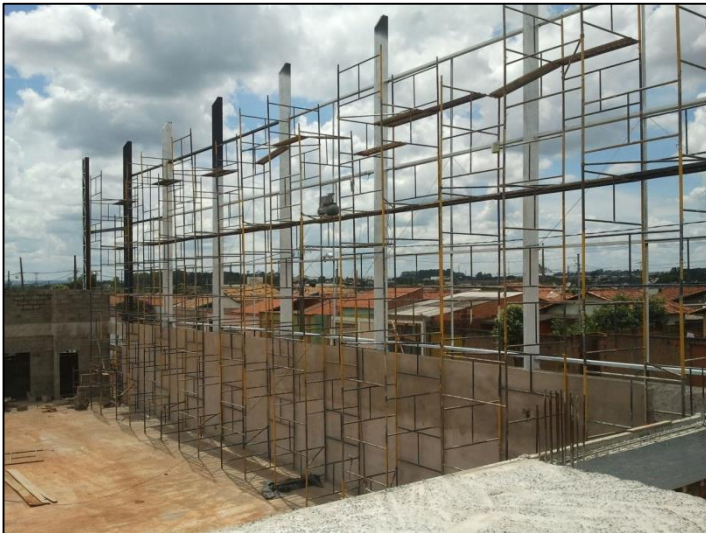
Figura: Pilares laterais - CIE Uberlândia/MG Fonte: autores
