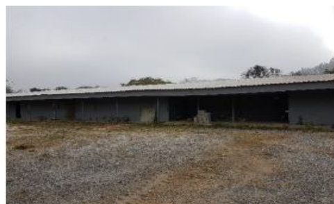
Obra paralisada, Guararema/SP
