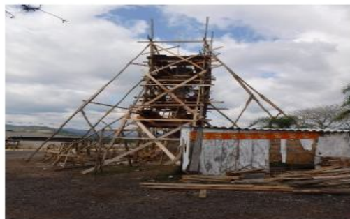
Atraso na execução da obra, Encantado/RS
