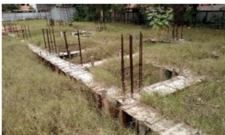
Obra paralisada – CIE São Gonçalo/RJ
